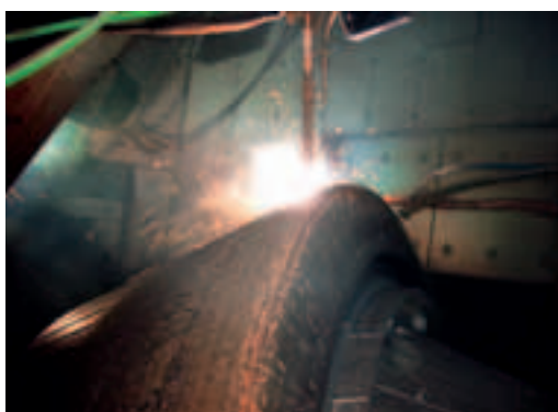
Наварка облицовки валков в мельнице
