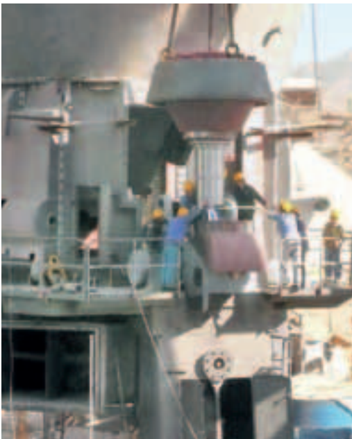
Установка мельницы LM 56.3+3 CS Рас-Эль-Хайма, Объединенные Арабские Эмираты, 2007
